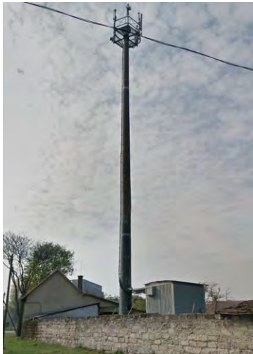
Önálló antennatartó szerkezet (XXII. ker., Vágóhíd u.)
